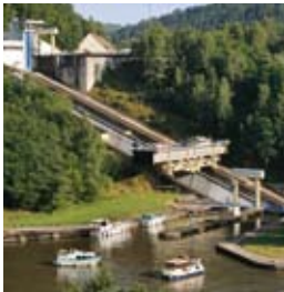
dann folgt das Schiffshebewerk Arzwiller,
