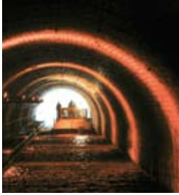
Die Route der Wasserstraßen-Bauwerke beginnt mit zwei Tunnels,
